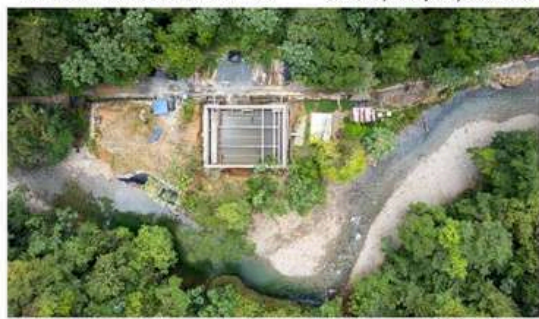
Vista aérea de la planta de tratamiento de agua potable sobre el río Escalerete que debe ser optimizada para mejorar el servicio.
