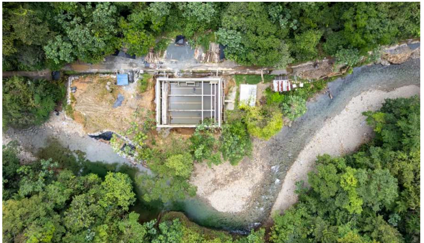
Vista aérea de la planta de tratamiento de agua potable sobre el río Escalerete que debe ser optimizada para mejorar el servicio.
