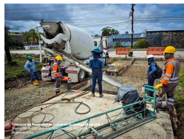
Trabajos de Fundición de Losas en la Unidad Funcional 1 Tramo PR. 4+250 a 4+500 (Sector: Club Zabaletas) Buenaventura
