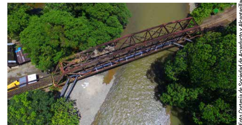
VISTA AÉREA del puente férreo sobre el cual se sostiene la tubería provisional instalada para superar la emergencia que dejó al 70% de la ciudad sin agua por 15 días.
